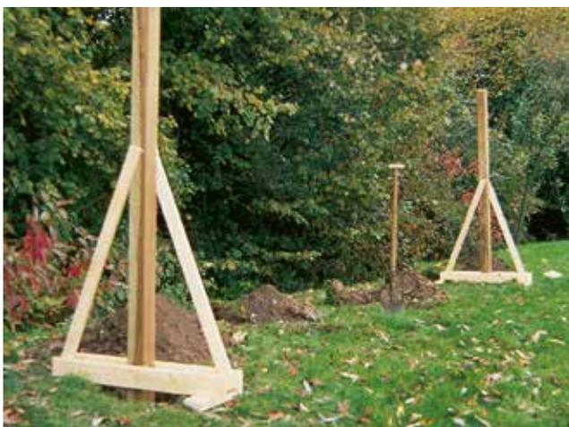
Montagehilfe zur Ausrichtung von Sichtblenden-Modulen
