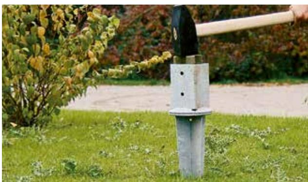
**Pfostenanker – zum Einschlagen:** Die schnellste Art, einen Pfosten zu setzen. Eine bewegliche Hülse erlaubt die nachträgliche Ausrichtung des Pfostens.
