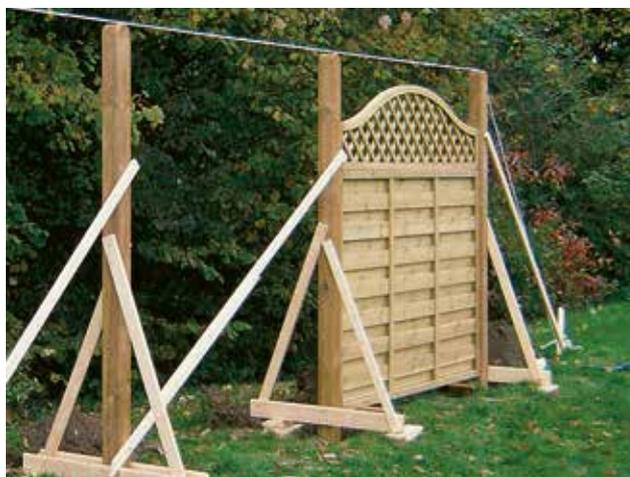
Die genaue Längsausrichtung klappt mit einer Spannschnur.
